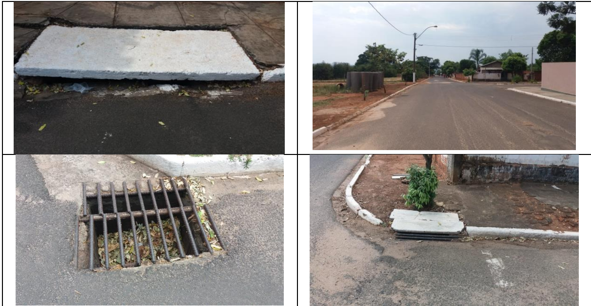
FOTOS C – DRENAGEM URBANA - 2019
