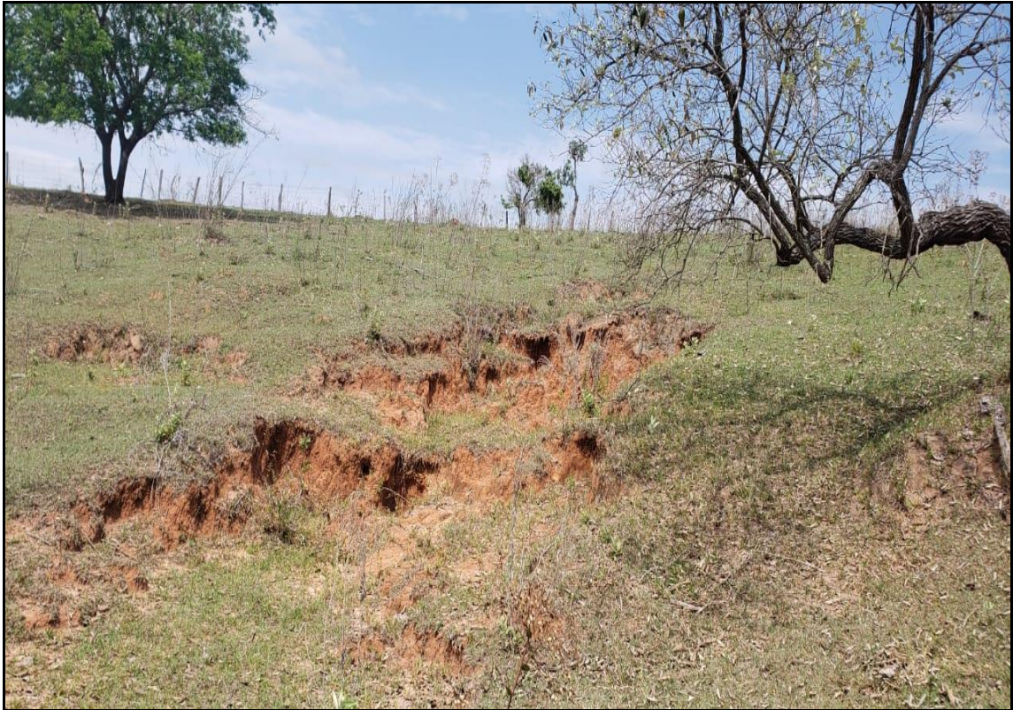
Figura 3 – Início de processo erosivo causado pelo lançamento inadequado das tubulações existentes no local.
