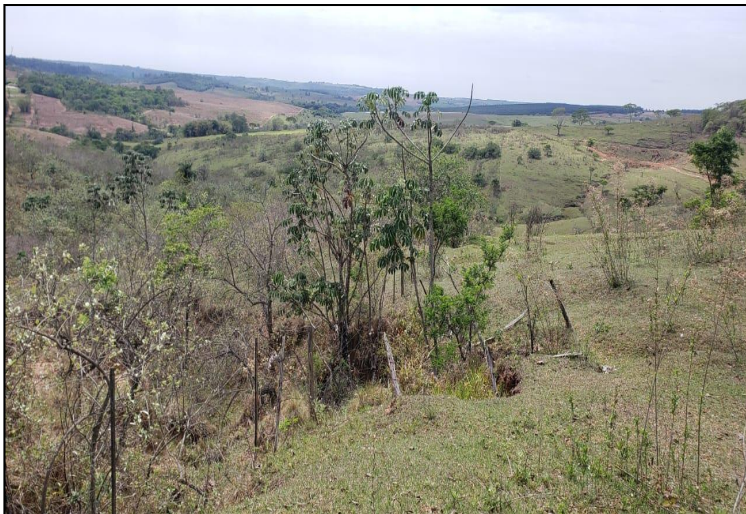
Figura 5 – Cerca de divisa da propriedade por onde serão executadas as obras de drenagem projetadas.
